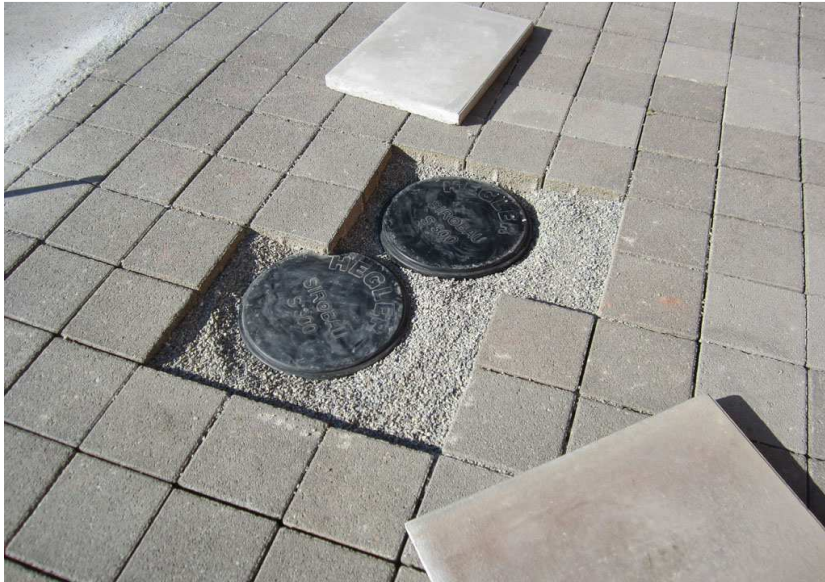
Im Bild: Freigelegter Schacht im Außenbereich zur Sonde.
